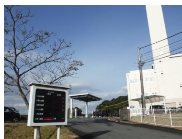
焼却後の主灰・飛灰を溶融してスラグやメタルにする施設を見学しました。
