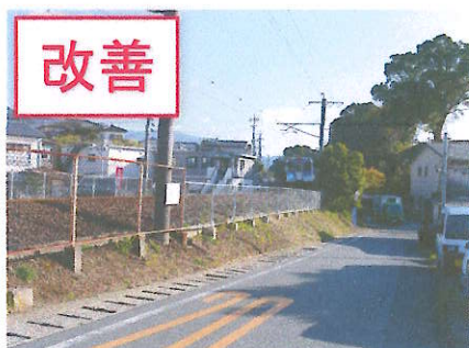
① フェンスがなく危険 新しい柵の設置
