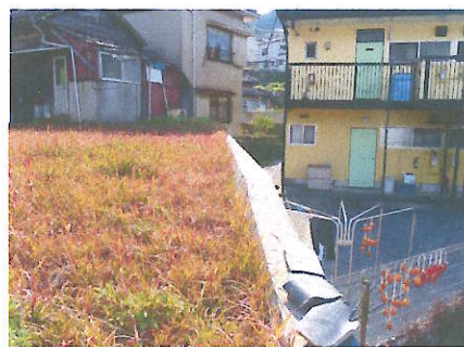
③ 空き地 フェンスがなく危険
