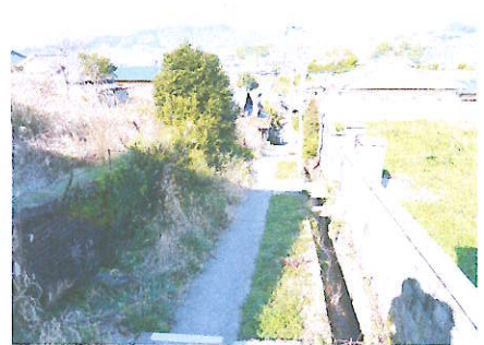
⑫ 溝蓋のない側溝があり注意
