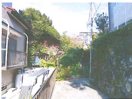
② 空き家 倒壊の危険
