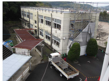
足場の解体作業の様子
